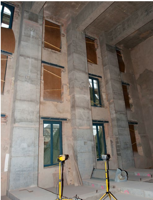
3-geschossige Rahmenkonstruktion 1. bis 3.OG, Freiraum
