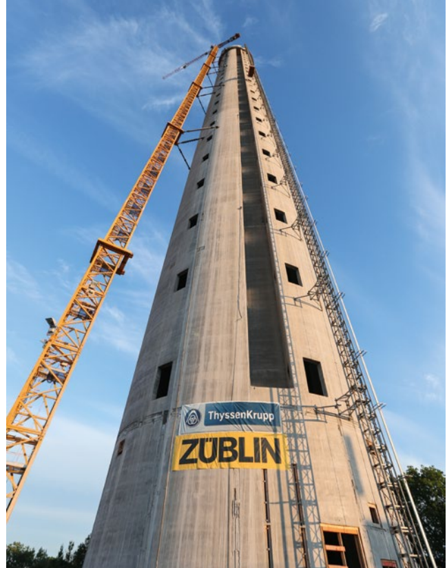
Ansicht des Turms beim Richtfest am 29. Juli 2015 – deutlich sichtbar ist die Wandöffnung, in die später der Panorama-Aufzug integriert wird
