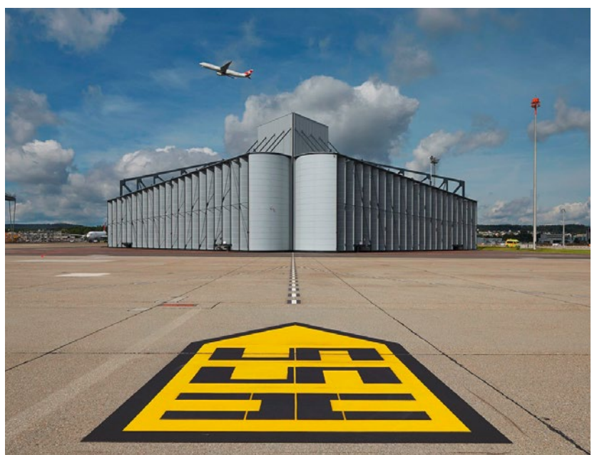
Lärmschutzhalle Zürich mit geschlossenen Toren
