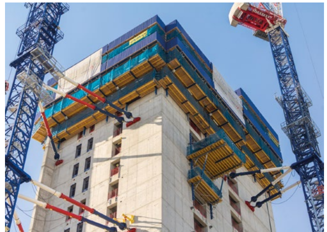
Der Gebäudekern ist in drei Abschnitte unterteilt und wurde mit der Selbstkletterschalung SKE100 plus und SKE50 plus errichtet.
