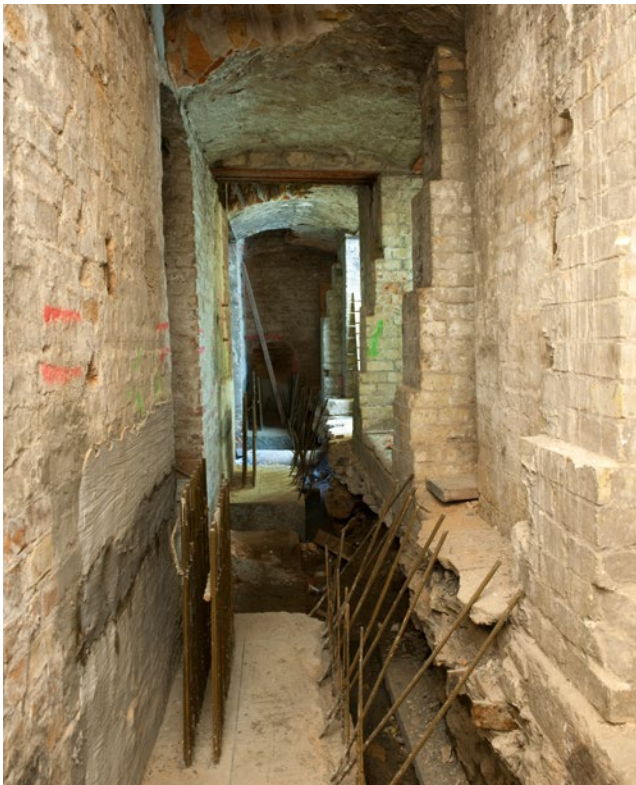
Mauerwerkskonstruktion im KG vor Umbau
