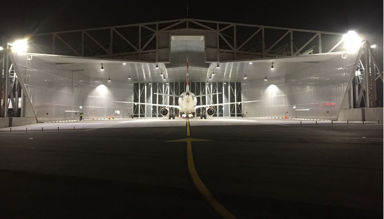
Lärmschutzhalle Genf zur Einfahrt bereit
