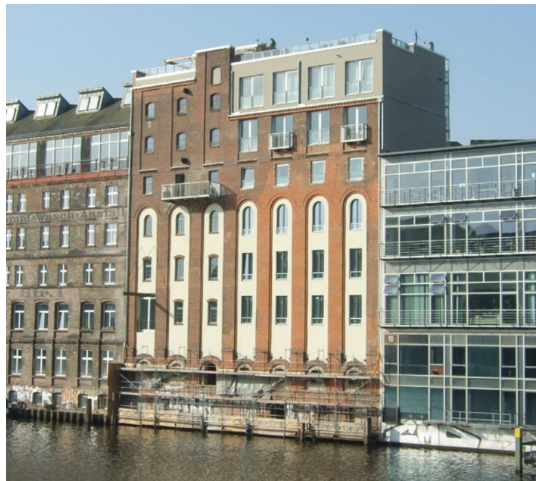
Ansicht Getreidesilo während des Umbaus
