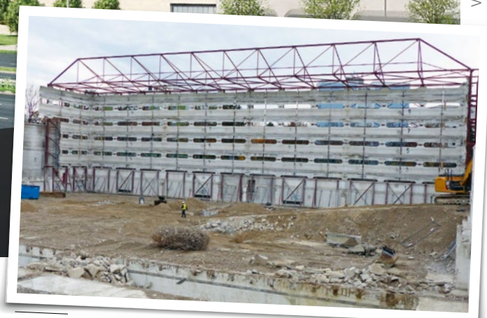
Vom Bestandsgebäude bleibt nur die Fassade stehen.
