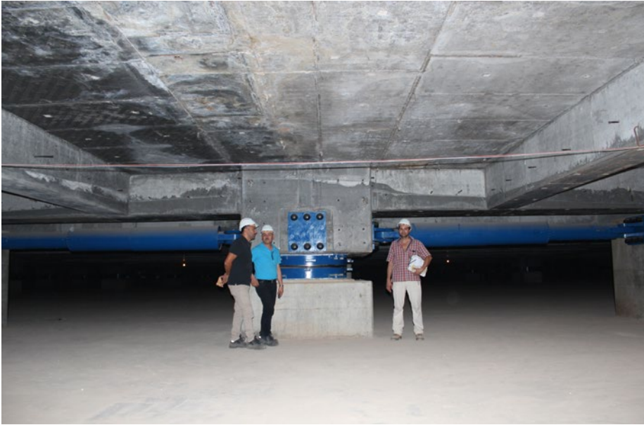
Ein SIP-Gleitpendellager und zwei horizontale adaptive Hydraulikdämpfer unter der Moschee von Algier. Die Personen verdeutlichen die Größenverhältnisse.
