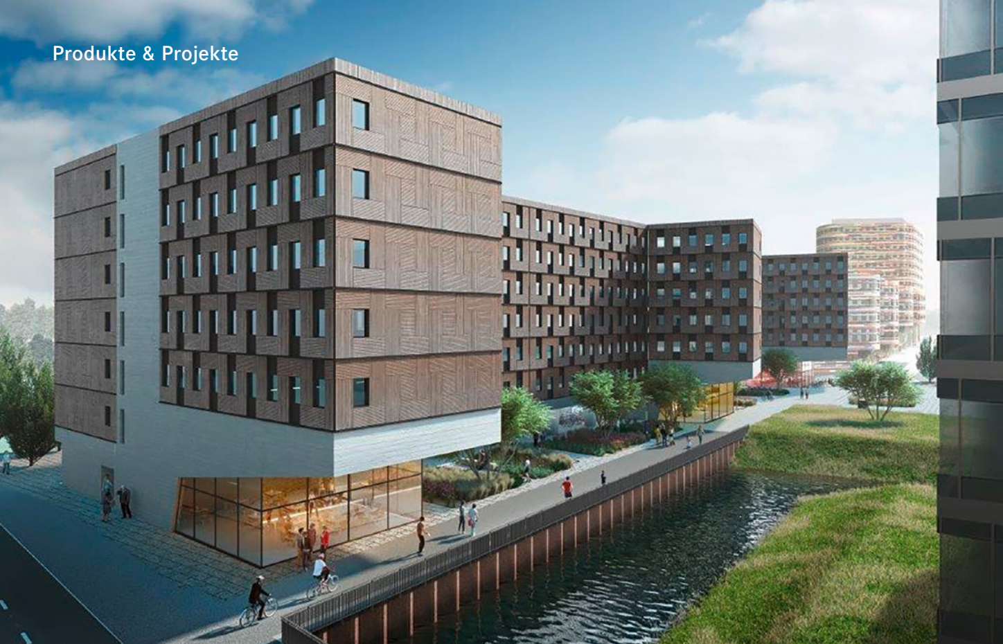
Hamburgs größtes Holzhaus – ein Studentenwohnheim – mit Getzner-Schallschutz.
