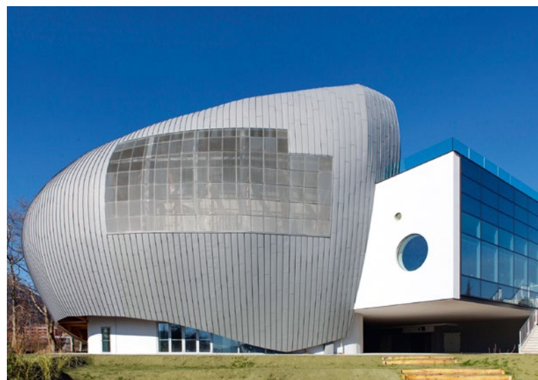
Das vorbewitterte Titanzink lässt sich auch an den gerundeten Übergängen von der Fassade zum Dach flexibel verarbeiten.
