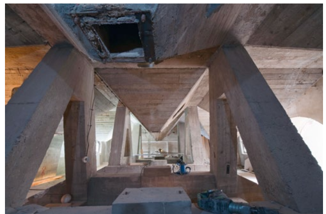
Stahlbetonkonstruktion im EG vor Umbau
