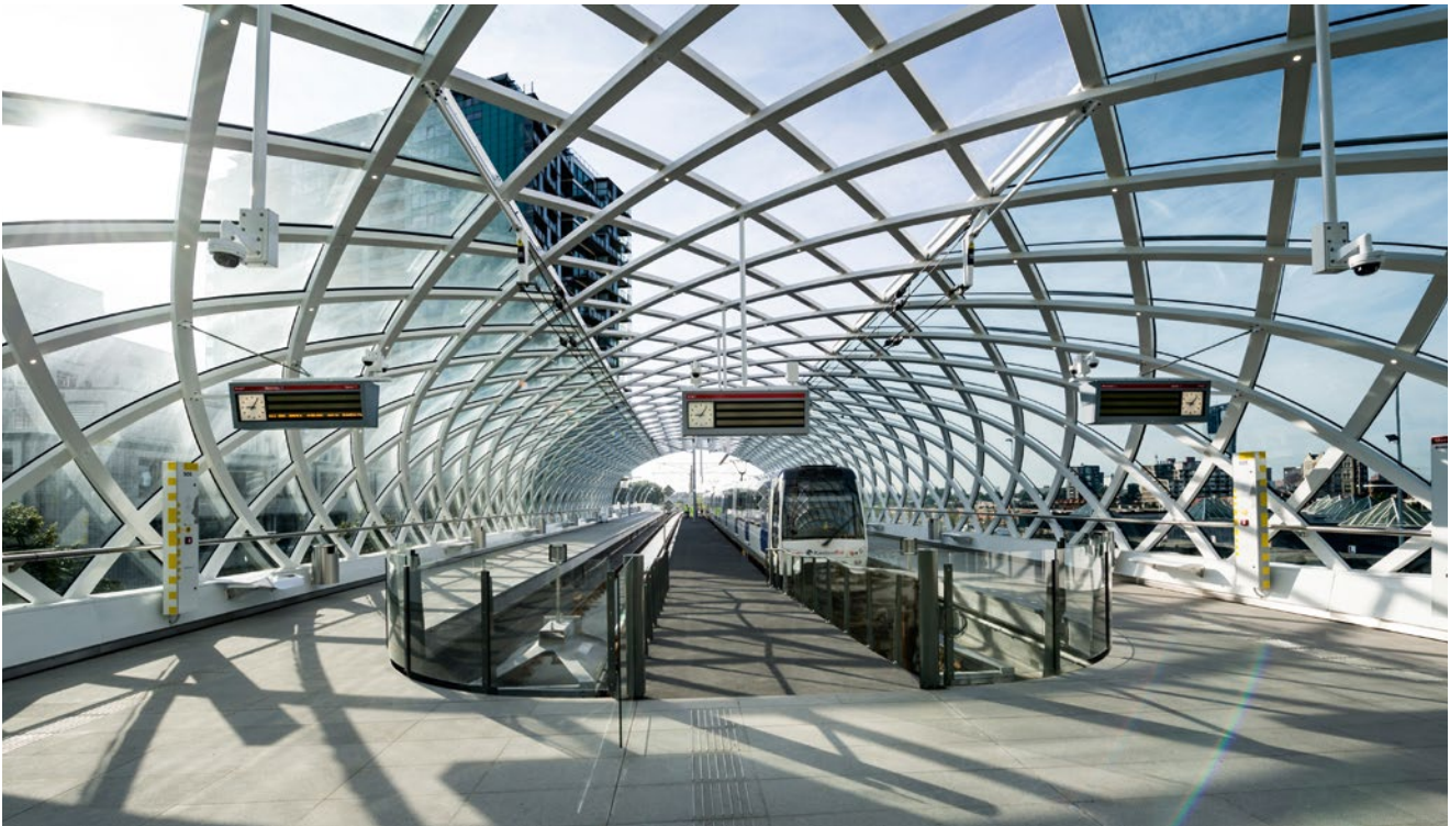
Dachkonstruktion im Gleisbereich
