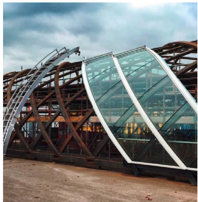
1:1-Segment des Tonnengewölbes
