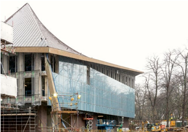
Während des Umbaus
