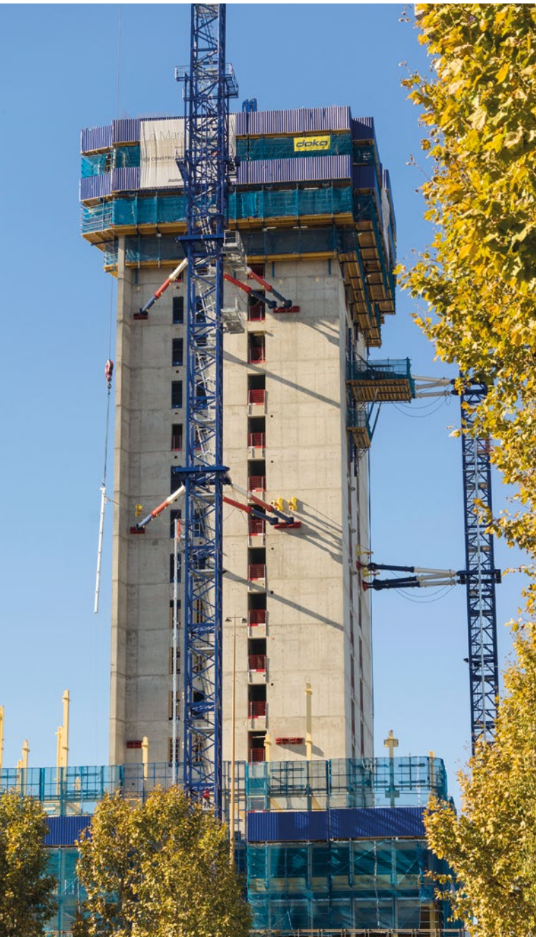
Der Gebäudekern ist in drei Abschnitte unterteilt und wurde mit der Selbstkletterschalung SKE100 plus und SKE50 plus errichtet.
