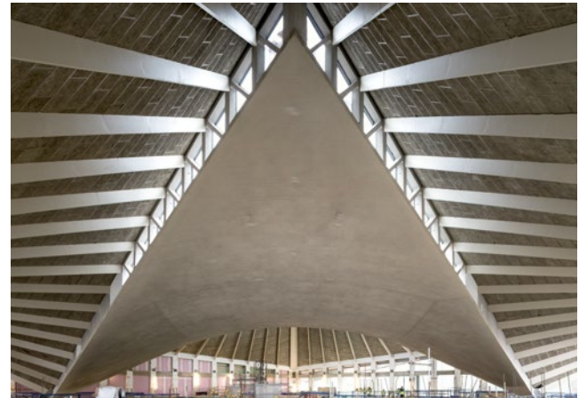
Das Schalentragwerk während der Bauphase
