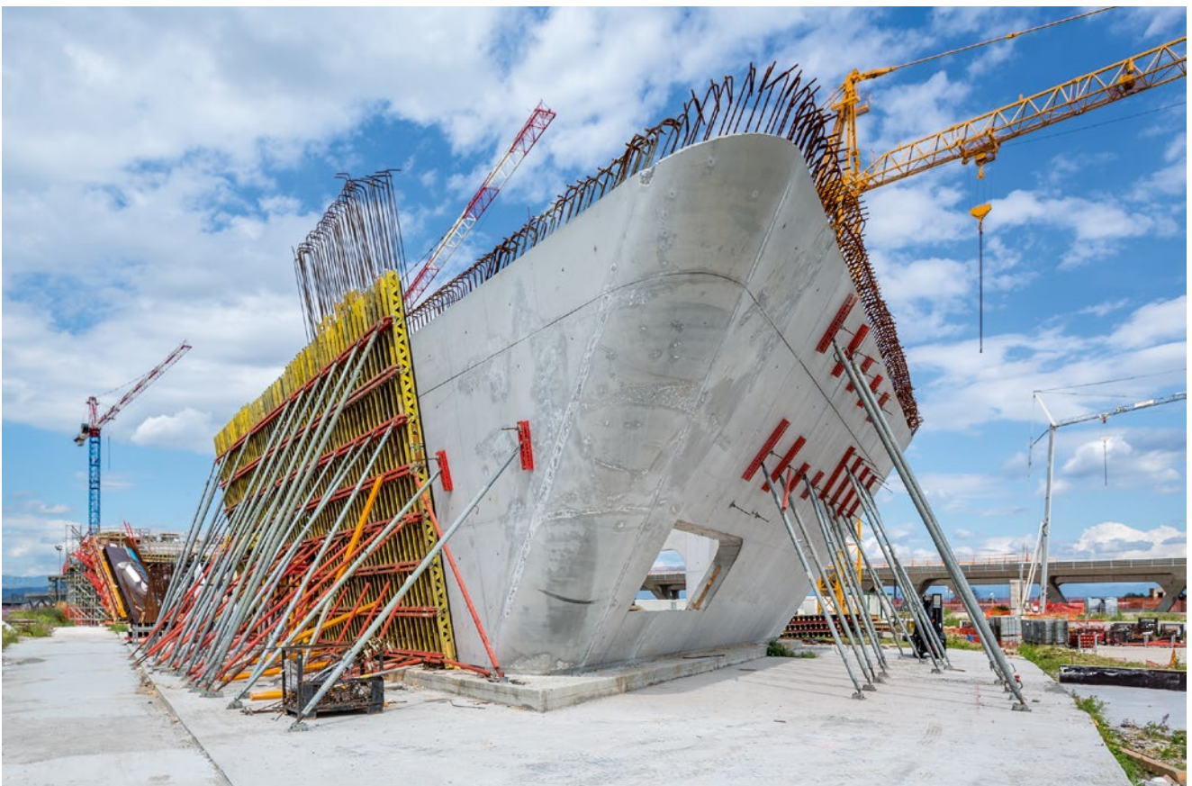
Für gekrümmte und geneigte Wände wurden Elemente der Wandschalung VARIO GT 24 maßgenau geplant und vorgefertigt.
