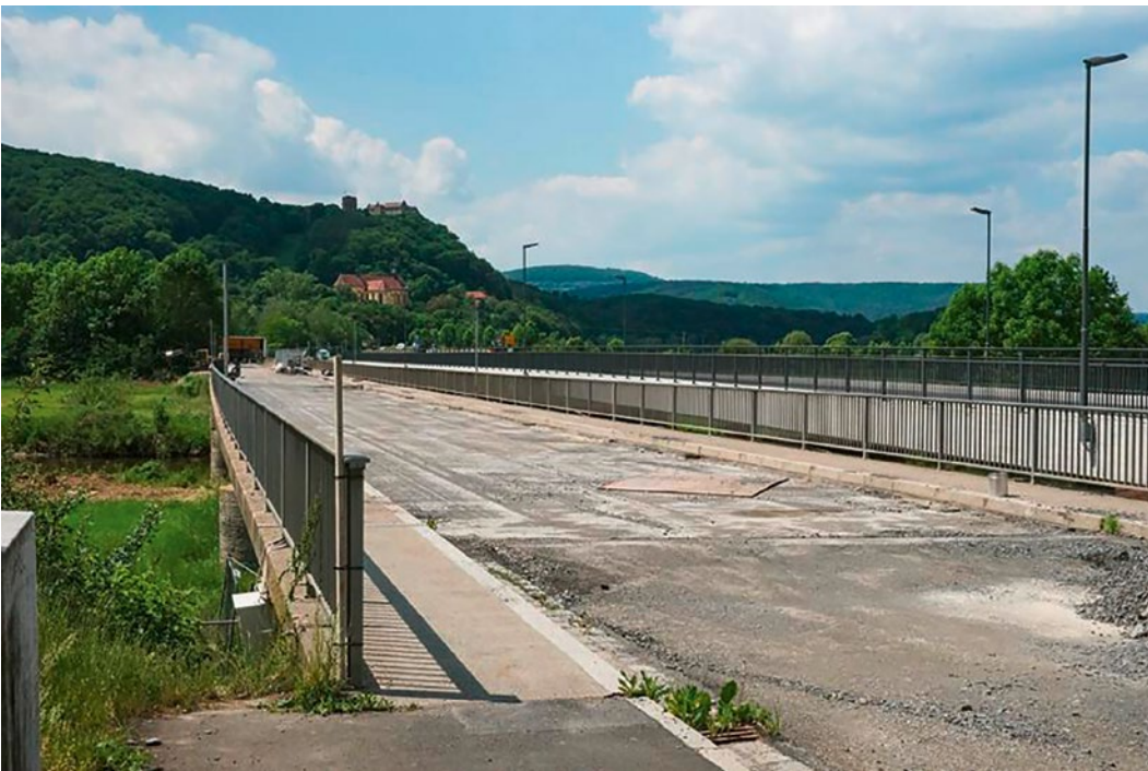
Die alte Saalebrücke in Hammelburg.
