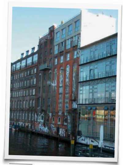
Ansicht Getreidesilo vor Umbau
