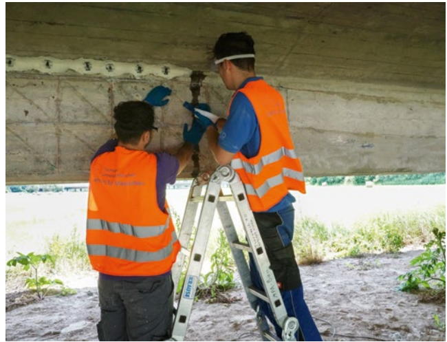
Das Messteam beim Aufkleben faseroptischer Sensoren.
