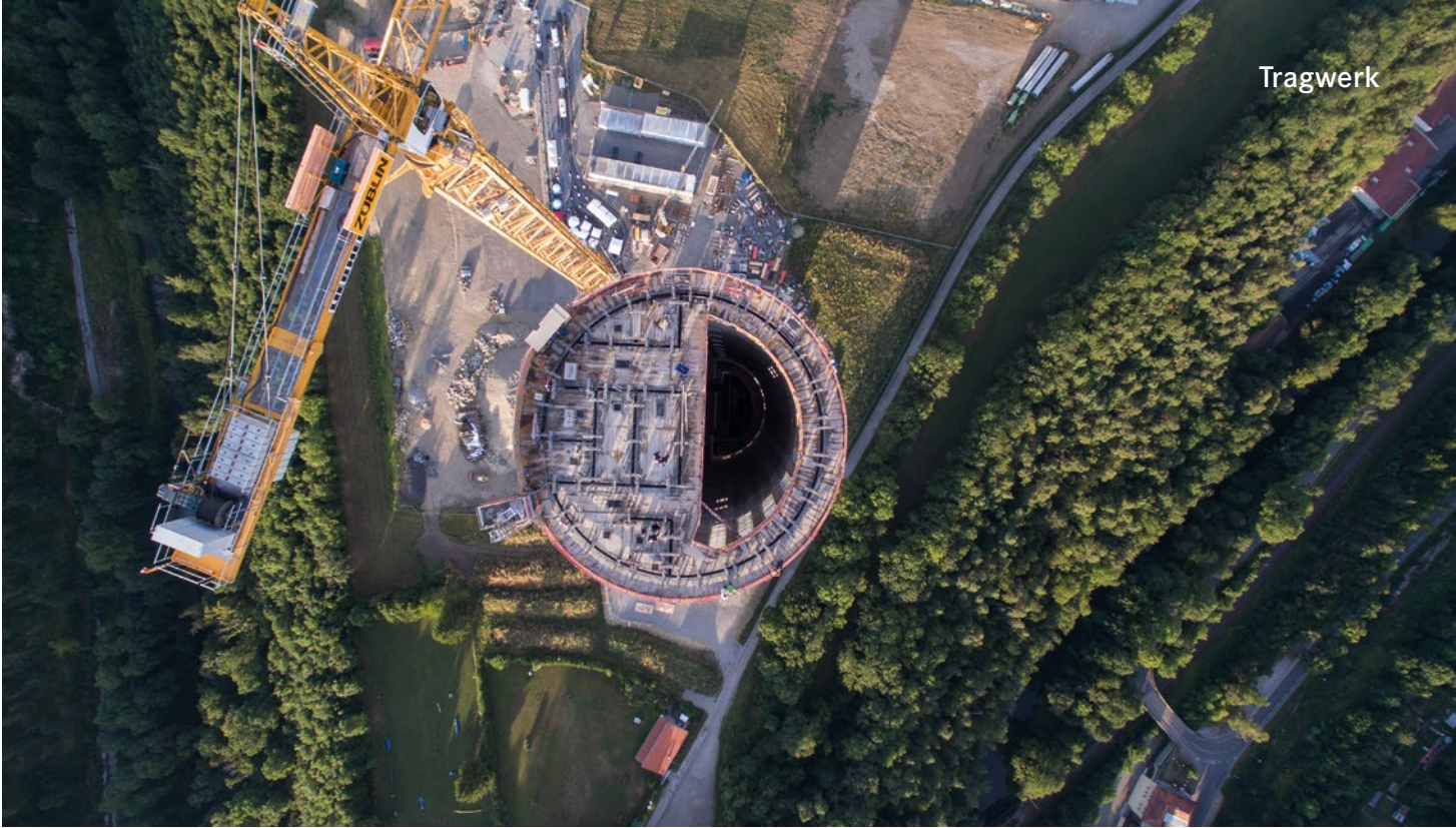
Aufsicht Frühsommer 2015 – in der rechten Gebäudehälfte ist der als Wärmespeicher genutzte Hohlraum sichtbar
