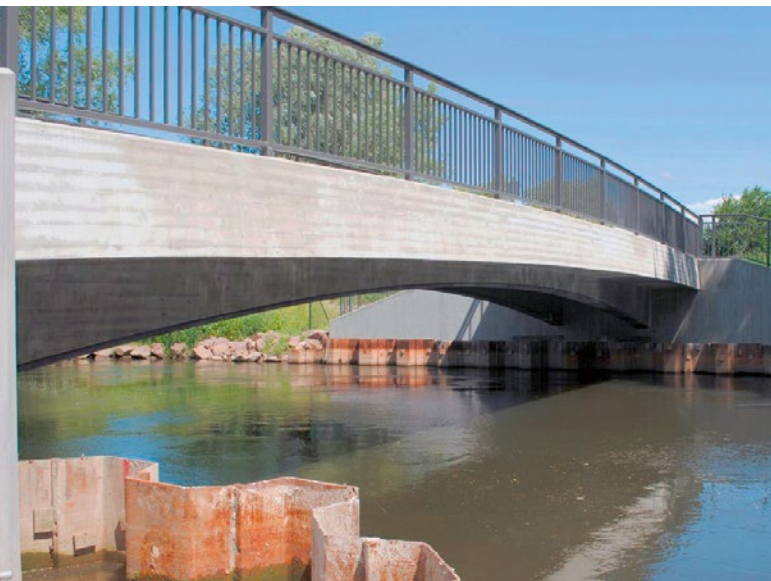
Die Elster-Brücke in Halle ist Deutschlands erste Stahlverbundbrücke mit feuerverzinkten Verbunddübeln.
