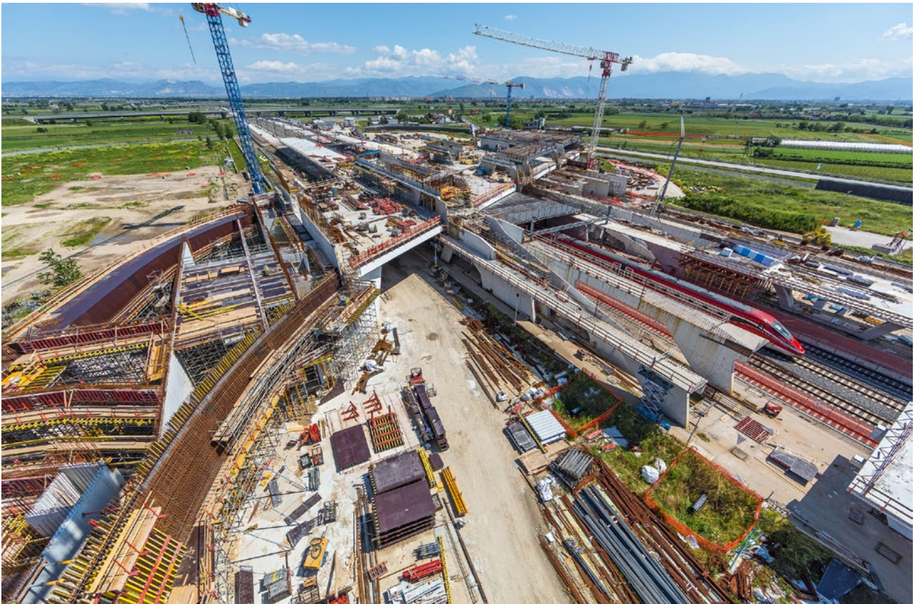
Die vielfach geschwungenen Formen stellten hohe Anforderungen an Schalung und Sichtbeton.
