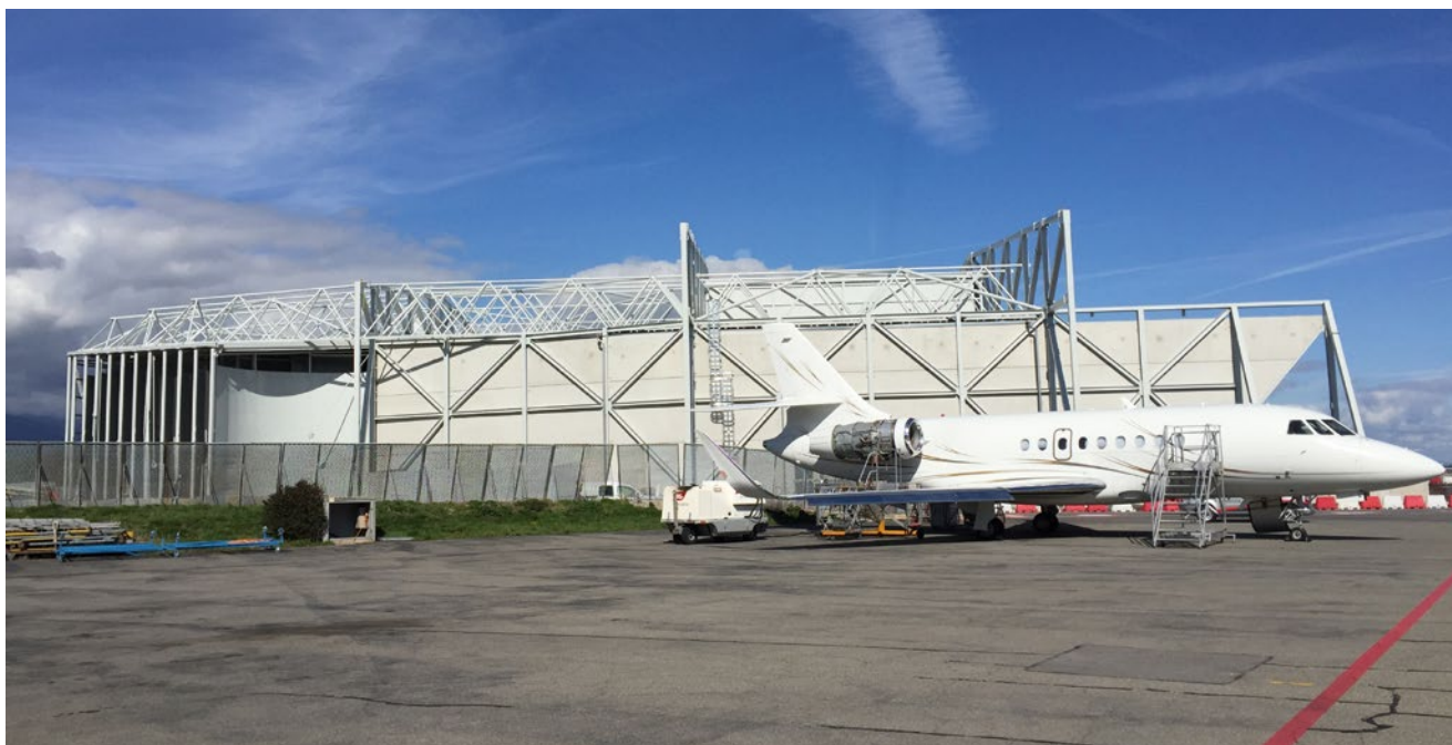
Seitenansicht der Lärmschutzhalle Genf
