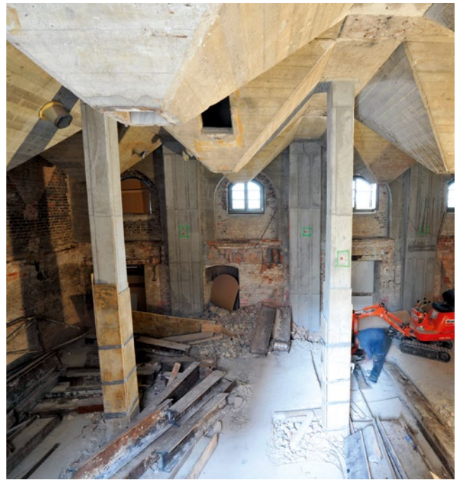
Einbau Stahlbetonstützen EG, KG
