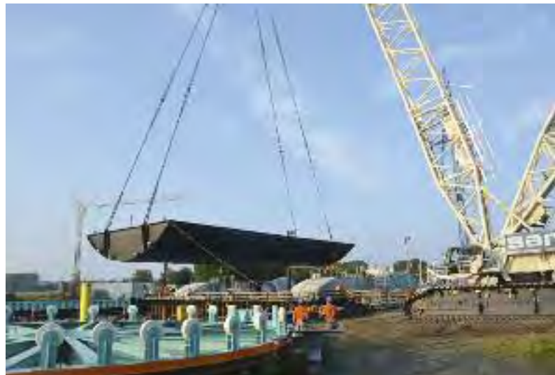
▲ Einheben des 100 t schweren Drehsegments
