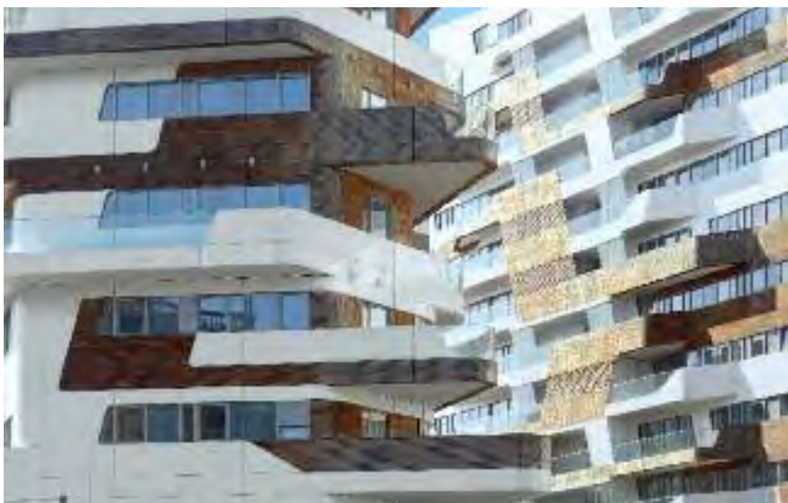
▲ Die Gebäudehüllen bestehen aus unterschiedlich dimensionierten Paneelen, kombiniert mit Naturholzflächen. Abbildungen: Schüco International Italia
