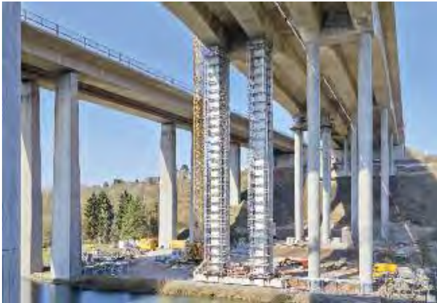
▲ Arbeitsgerüste und Baustellenzugang für den sicheren Hilfspfeiler-Abbruch an der Lahntalbrücke waren schnell auf- und abgebaut.
