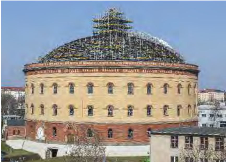
▲ Schnelle Montage und sichere Arbeitsebenen waren Voraussetzung für die Sanierung des Gasometers in Leipzig. Foto: PERI GmbH
