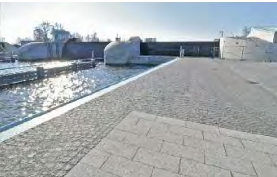
▼ Drehsegment und ein Schiebetor während einer Funktionsprobe geschlossen
