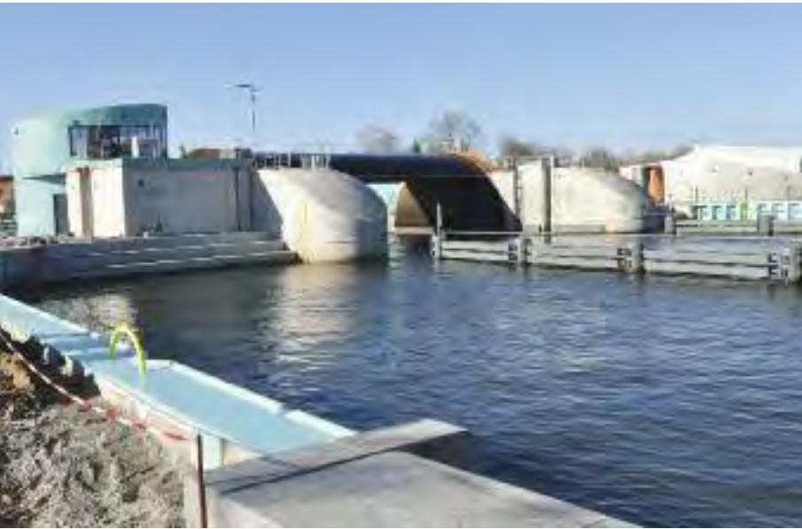
▲ Blick von der Seeseite, Drehsegment in Revisionsstellung
