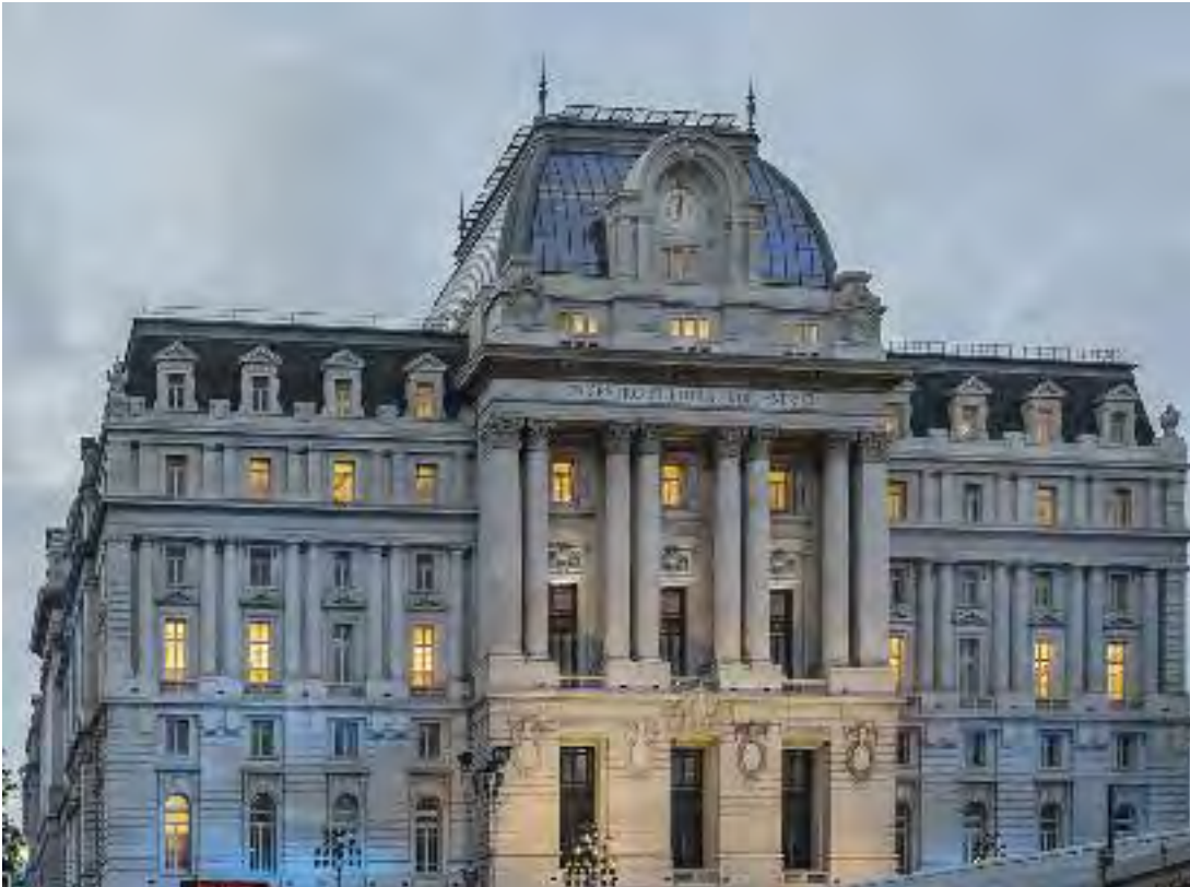
◀ Das Néstor Kirchner Kulturzentrum in Buenos Aires Foto: GKD+formTL/ Jackie Rios
