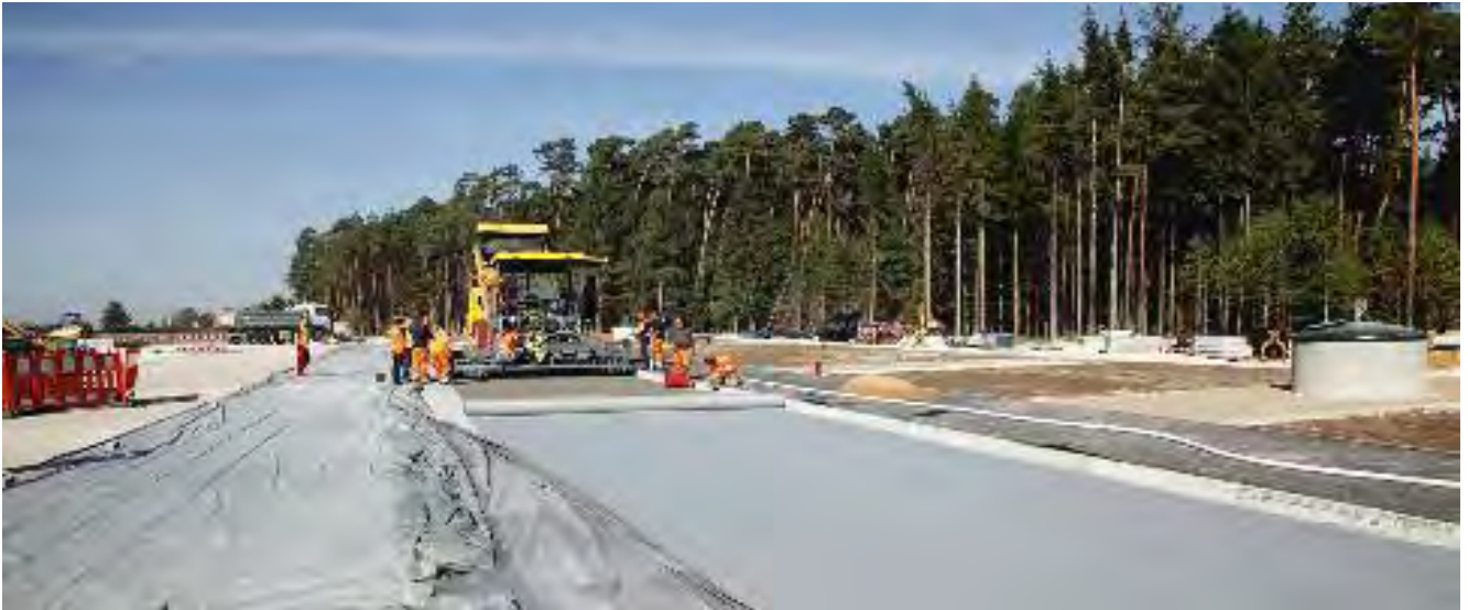
▲ Vliesabdeckung, um den OPB vor dem vorzeitigen Austrocknen zu schützen. Fotos: Leonhardt Weiss
