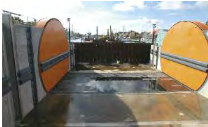
▼ Das zwischen den Pfeilern eingebaute Drehsegment in der gelenkten Baugrube
