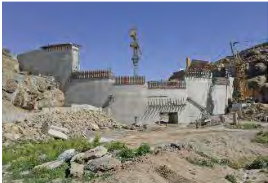
▲ Teile der auskragenden Dammkrone sind mit Sperrenkonsolen SPK 270 eingeschalt, die mit TTR-Elementen belegt sind.
