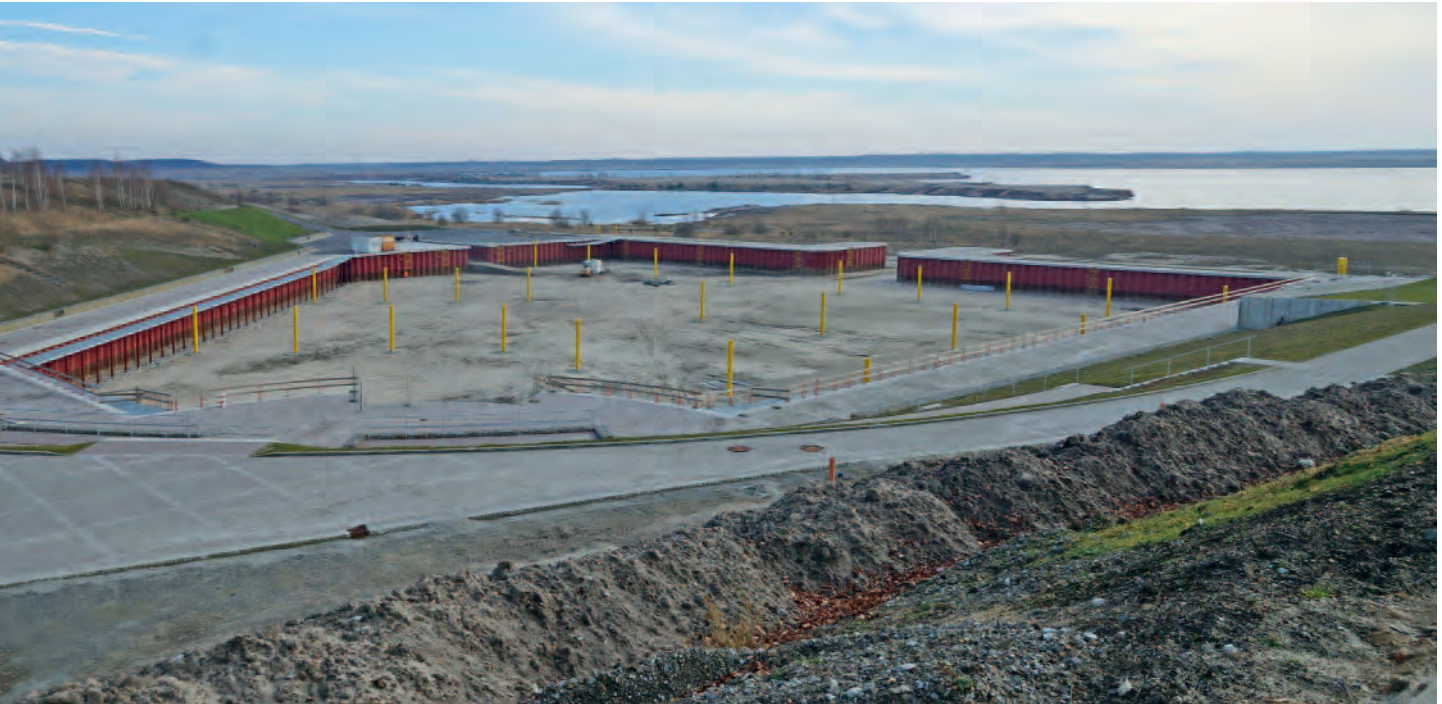
▲ Hafenbecken gerammt (Februar 2016)
