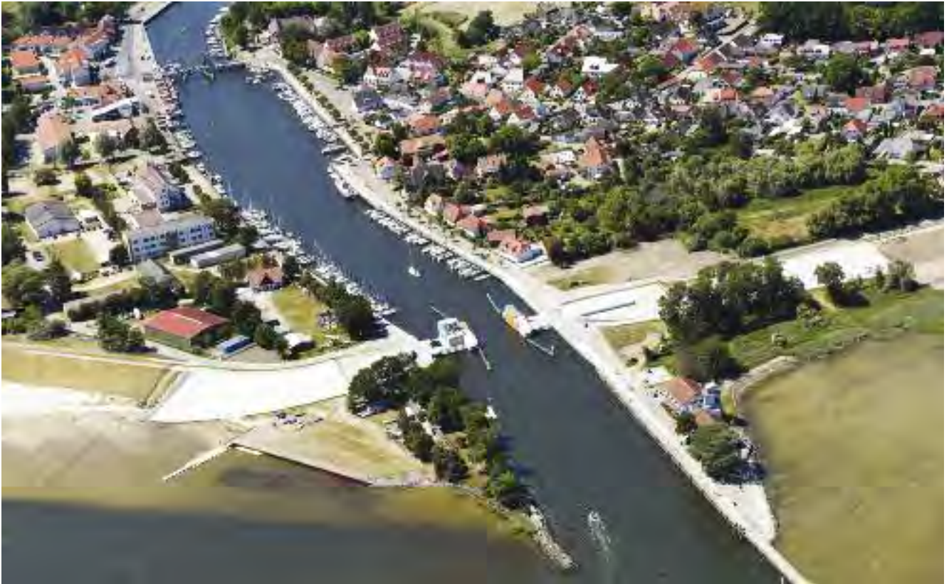
▲ Das neue Sperrwerk aus der Luft
