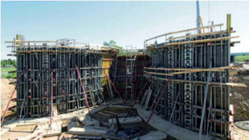
◀ Geschalte Flügelwände für die B-174-Brücke bei Chemnitz
