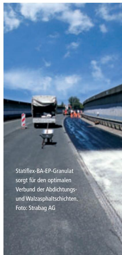
Statiflex-BA-EP-Granulat sorgt für den optimalen Verbund der Abdichtungs- und Walzasphaltschichten.
