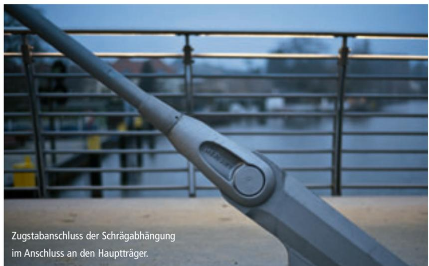
Zugstabanschluss der Schrägabhängung im Anschluss an den Hauptträger.
