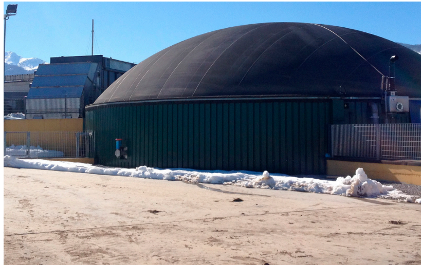
Abb. 3.1.5.2: Biogasanlage | Quelle: RENAC
