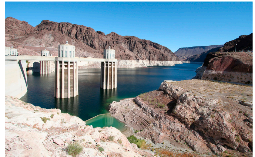
Abb. 3.1.8.2 Wasserkraftwerk | Quelle: Fotolia
