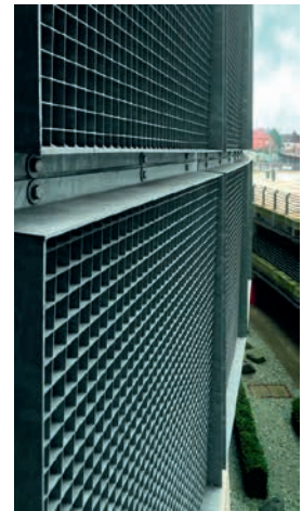
Gitterrostfassaden-Detail Fotos: Institut Feuerverzinken
