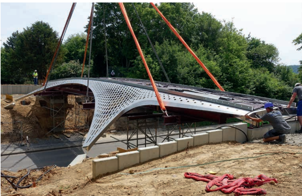
Einheben der Schalenkonstruktion
