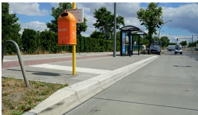
Hester-Projekt in Berlin: Bündiger Anschluss an die Bordsteinkante
