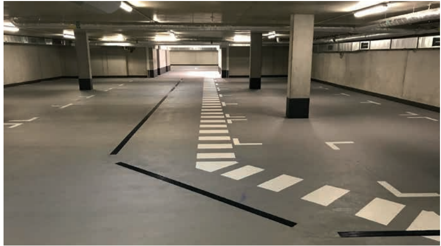
Neu beschichtete Tiefgarage in Spindlers Hof: Markante Punkte zur Erhöhung der Sicherheit sind farbig markiert.
