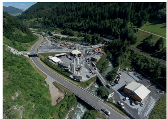
Luftbild Baustelle Wolf
