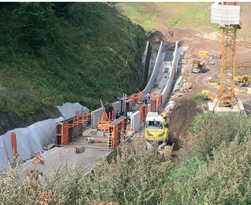
Schalungssystem LOGO.3. im Einsatz bei der Schussrinnensanierung im mittleren Bereich
