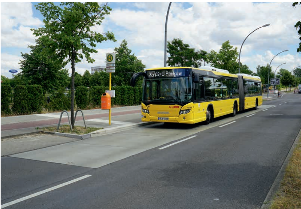
Demonstrator zum Projekt Hester in Berlin: Fahrbahn mit eingebautem Betonfertigteil
