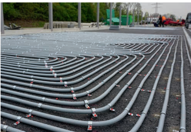
Seda-Demonstrator: Erprobung verschiedener Kollektorsysteme und Verlegesysteme
