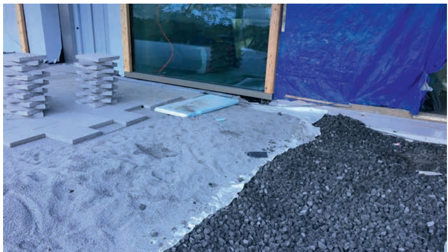
Schaumglasschotter: ein Leichtgewicht, einfach und schnell im Einbau.
