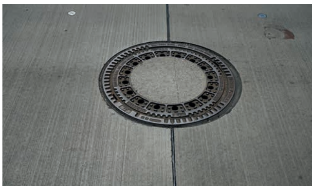
Hester-Demonstrator in Berlin: Passgerechter Einbau an vorhandene Kanalisation
