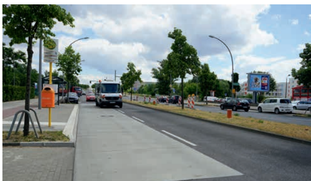
Hester-Projekt in Berlin: Nach kurzer Sperrung war der Verkehr wieder freigegeben
