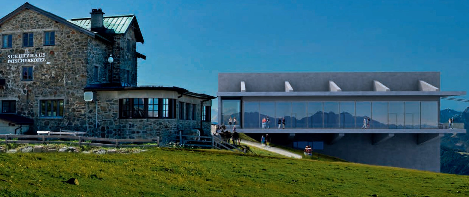
Baustelle in 1.965 m Höhe – die neue Bergstation der Patscherkofelbahn.
