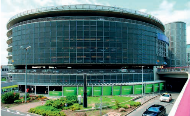
Wesentliche Gestaltungsmerkmale der beiden Parkrotunden sind die Form und die feuerverzinkte Gitterrostfassade.
