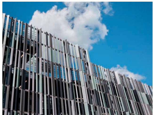
Die luftige Fassade besteht aus acht dreidimensional geformten Kanteilen in vier verschiedenen Grau- und Grüntönen.
